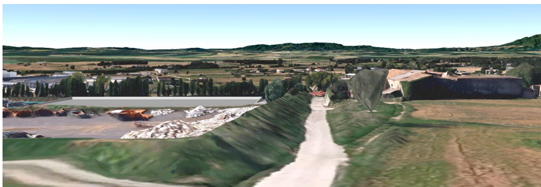
Vista amb la nova nau que encapsula conté la màquina de triturar des del camí de llebrer de dalt on s'observen les motes de protecció dels habitatges propers.
